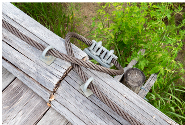
図 3-47 流れ橋の橋板と橋桁を結ぶロープ
